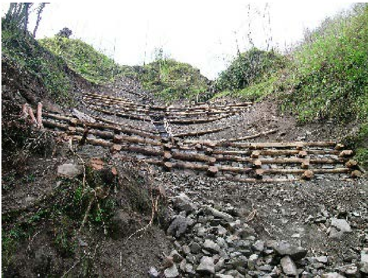
Opere di ingegneria naturalistica per la regimazione di un corso d'acqua in montagna. L'aumentata frequenza di eventi meteorologici estremi, dovuta ai cambiamenti climatici, impone l'adozione di interventi di adattamento. (Foto Giacomo Lorenzini).
